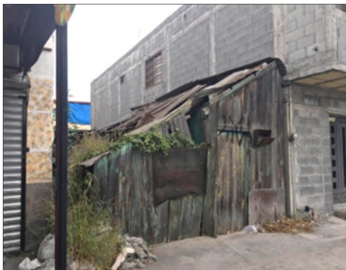
Foto de tejabán ubicado en la colonia Terminal, 2019
